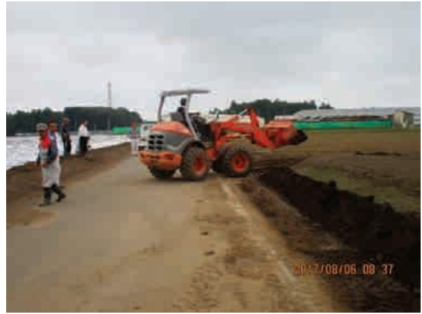
畦畔の再構築，農地法面の初期補修
