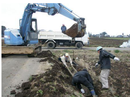
③ 水路の補修
