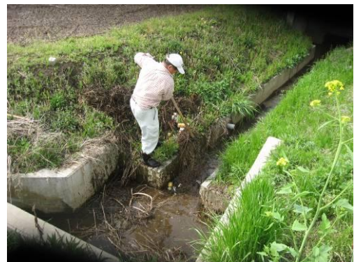
② 水路の泥上げ
