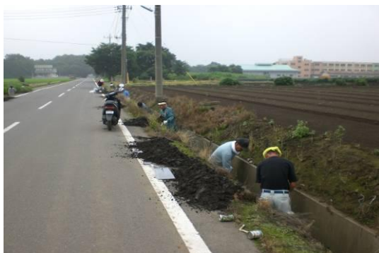
③ 農道側溝の泥上げ
