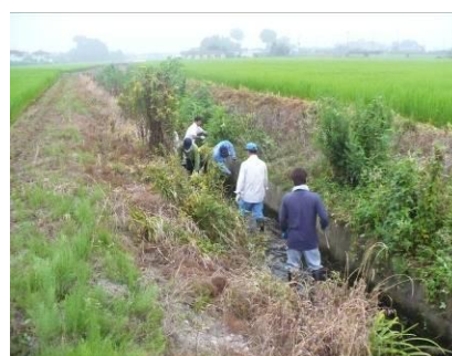
② 排水路の草刈り
