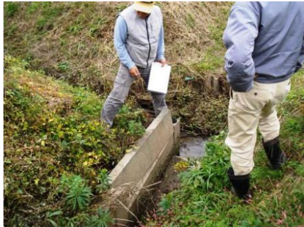
①水路の点検
