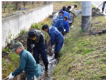
⑤水路の泥上げ
