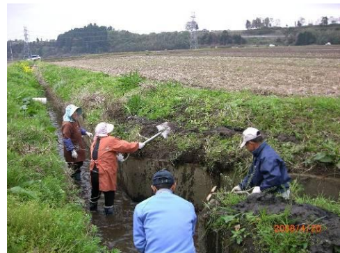
② 水路の泥上げ
