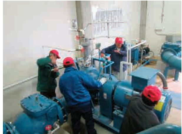
揚水試運転・施設の整備
