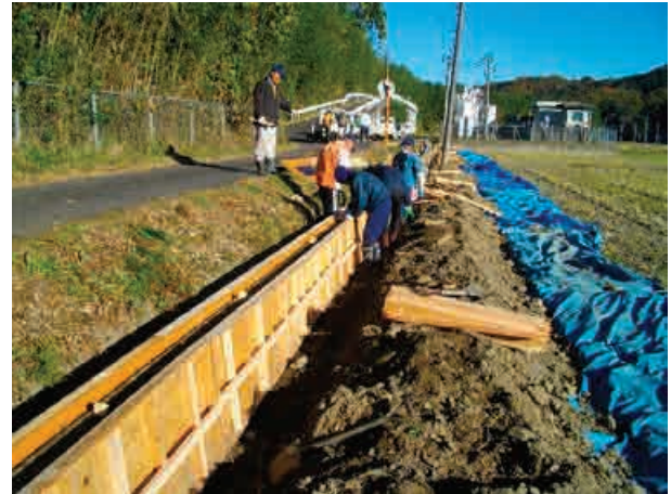
自主施工による水路の嵩上げ工事
