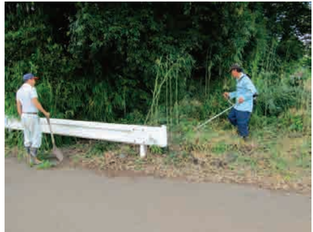
水路等の草刈り
