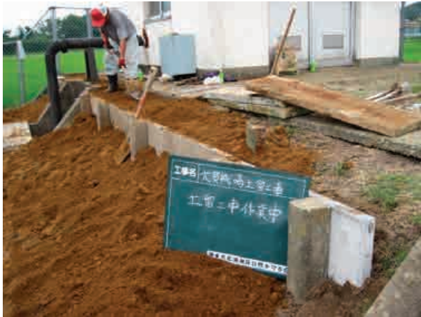
機場周辺の土留め工事
