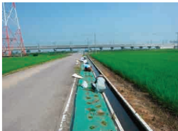
植栽地への防草シート設置・除草作業
