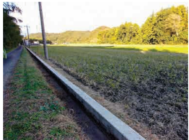
自主施工による嵩上げ工事済みの水路
