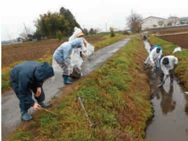
水路の泥上げ
