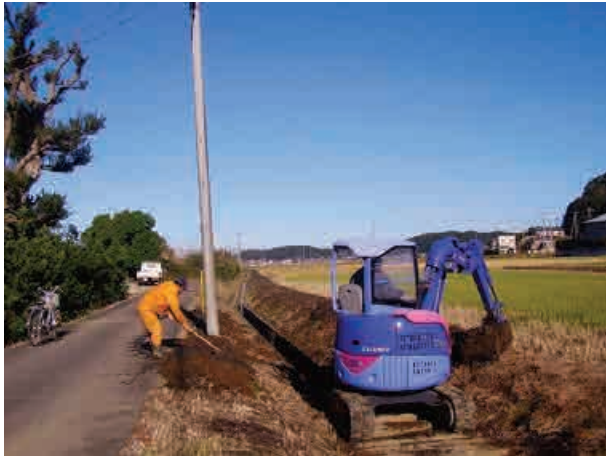
水路の泥上げ
