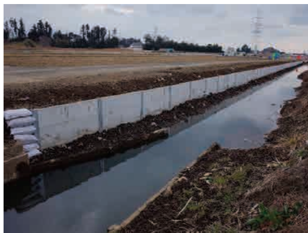
水路の補修（柵板の土留め）
