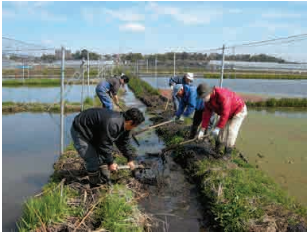
水路の泥上げ
