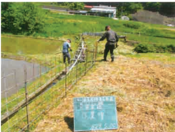
ワイヤーメッシュ柵の設置
