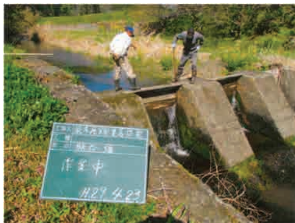
用水路の泥上げ
