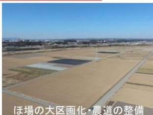
ほ場の大区画化・農道の整備
