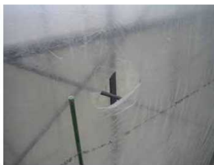
図Ⅱ-2-3 2重被覆の破れ
