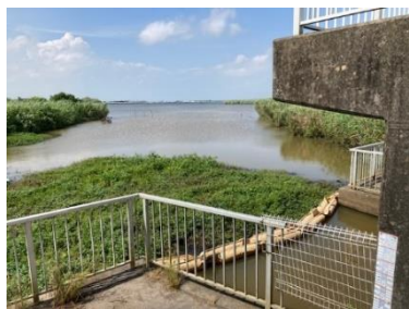
①侵入防止フェンス
