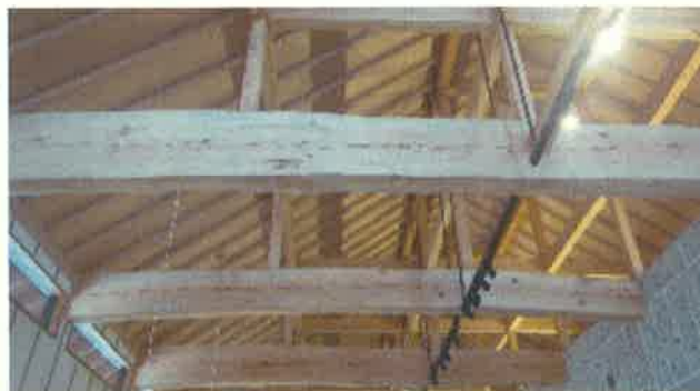
施設内部の様子（梁材）
