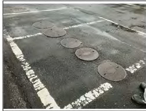
東側駐車場身障者トイレ
