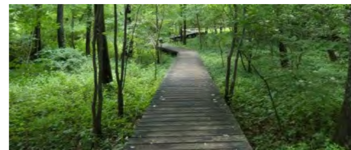
ゲートから温浴まで園路を整備
