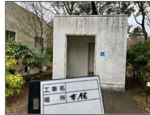
屋外(展示室北)トイレ全景
