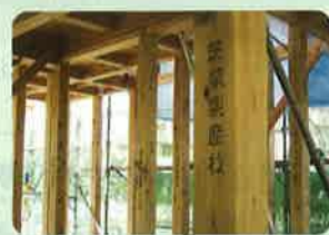
県産材を使った住宅の建築
