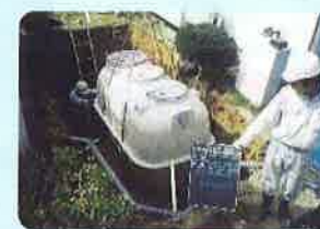
高度処理型浄化槽の設置
