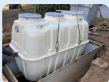
▲高度処理型浄化槽の設置
