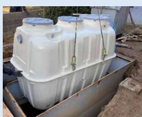
高度処理型浄化槽の設置
