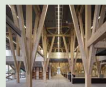
建築物の木造化(大子町新庁舎)
