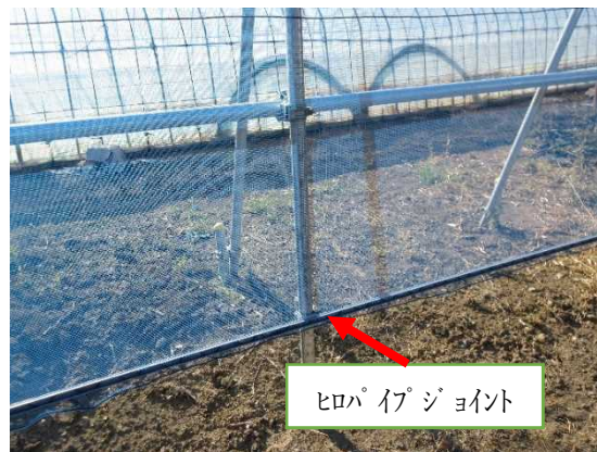
写真8 支柱と上部・中部・下部ビニベツト接合
