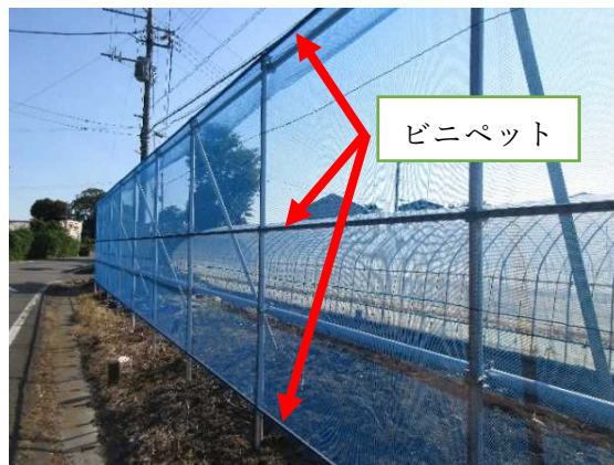
写真6 上部・中部・下部の3列のビニベツト
