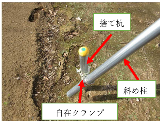
写真3 斜め柱と捨て杭の接合
