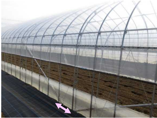
写真3 筋交いの設置間隔 (0~3m)
