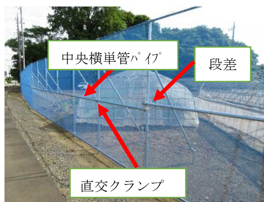
写真2 支柱と中央横単管パイプの接合
