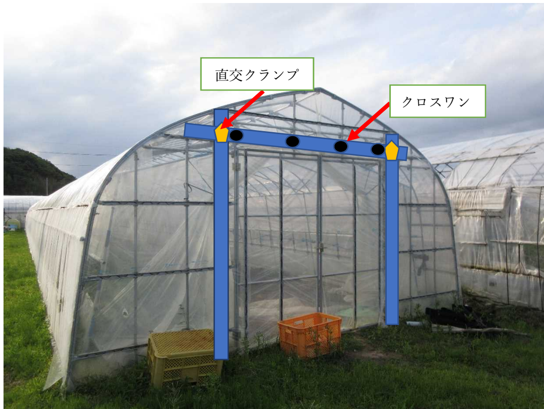
写真1 単管パイプ（径48.6mm 縦2.5m×2本、横2.5m×1本）設置（妻面内側）
