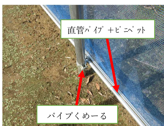
写真4 支柱と直管パイプの接合
