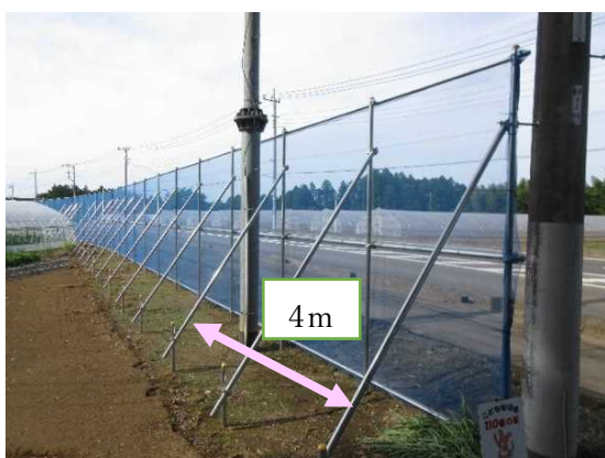
写真1 斜め柱の設置
