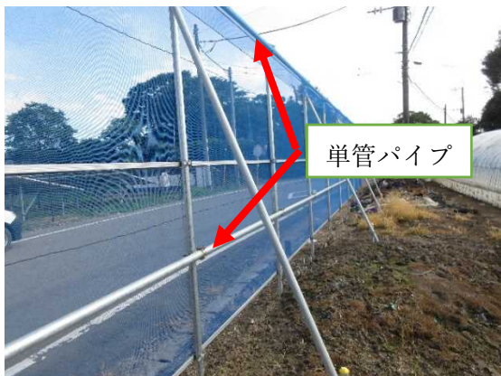
写真5 上部・中部下の2列の単管パイプ
