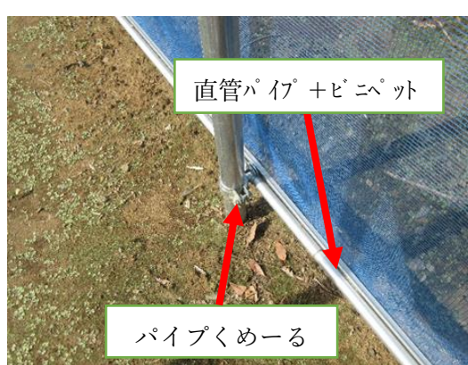
写真4 支柱と直管パイプの接合
