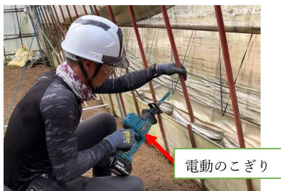
写真4 パイプの切断
