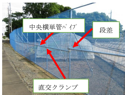
写真2 支柱と中央横単管パイプの接合
