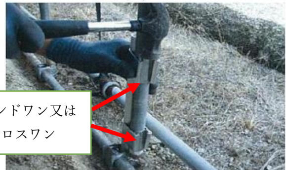
写真 2 新しいパイプとアーチパイプの接合
