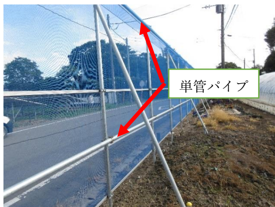
写真5 上部・中部下の2列の単管パイプ
