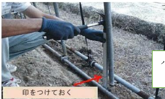
写真 1 新しいパイプを打ち込む
