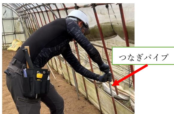
写真5 つなぎパイプの挿入
