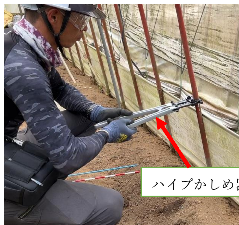
写真7 パイプかしめ器で固定
