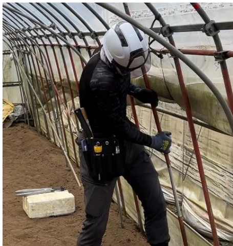
写真6 アーチパイプを上から被せる
