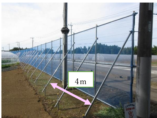
写真1 斜め柱の設置
