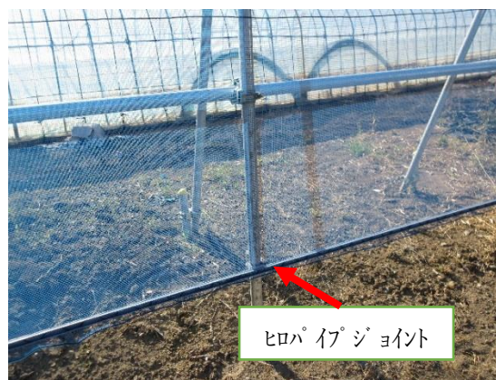
写真8 支柱と上部・中部・下部ビニベツト接続
