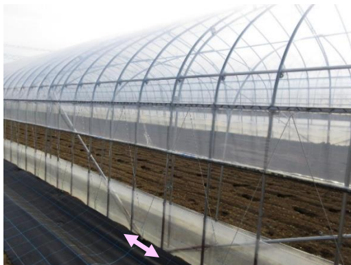
写真3 筋交いの設置間隔 (0~3m)
