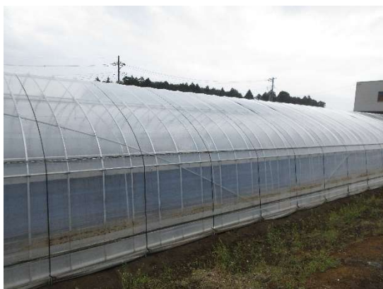
写真1 筋交いの設置状況
