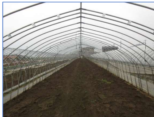
写真2 ダブルアーチ設置状況
