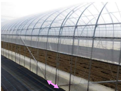
写真3 筋交いの設置間隔 (0~3m)
