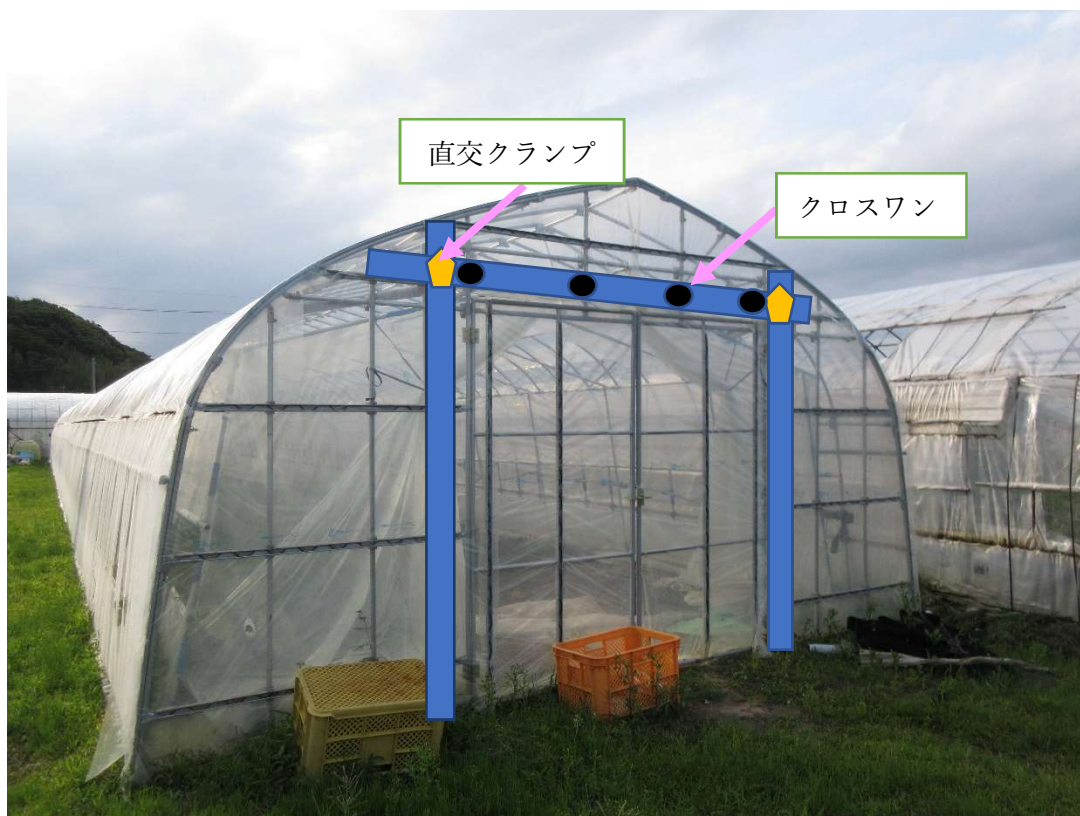
写真1 単管パイプ（径48.6mm）による補強
