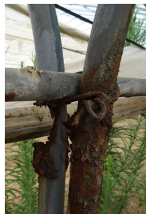
写真3 肩部の腐食
