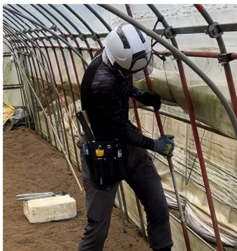
写真6 アーチパイプを上から被せる
