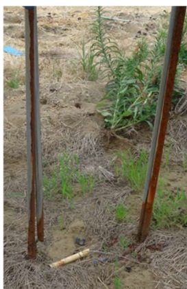
写真2 脚部の腐食
