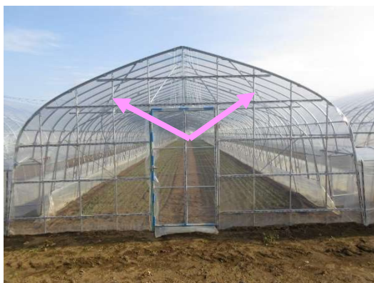
写真3 筋交いの設置間隔 (0~3m)
