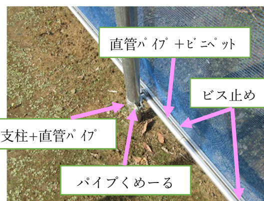
写真4 支柱と直管パイプ、直管パイプとビニネットの接合
