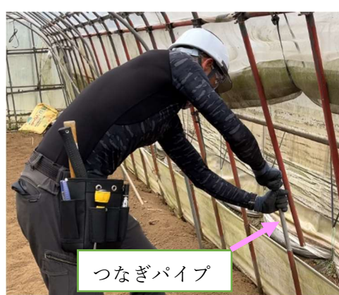
写真7 パイプかしめ器で締める
