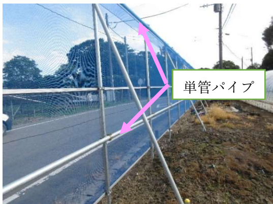
写真5 上部・中部下の横2列の単管パイプ
