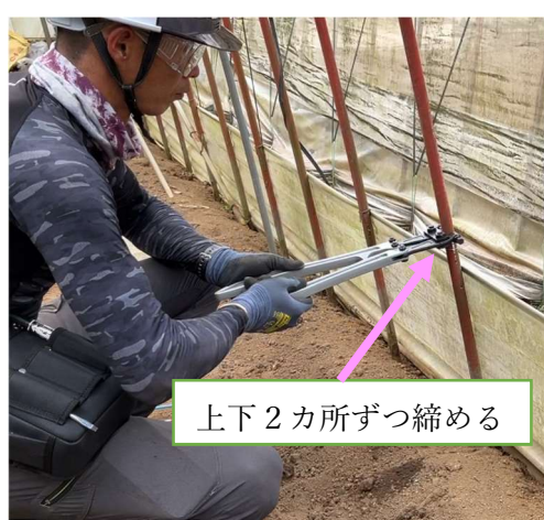
写真7 パイプかしめ器で締める
