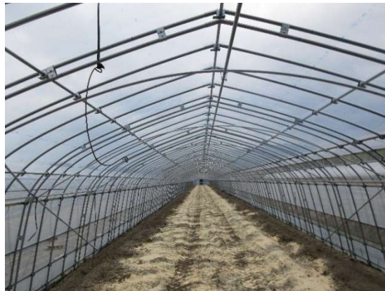
写真2 ダブルアーチの設置状況
