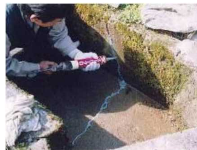
(図3)資源向上支払：水路の補修
