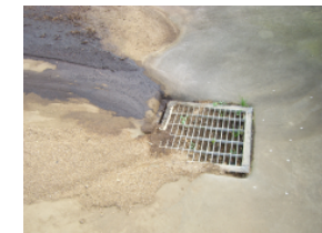
【○】排水施設の敷設
