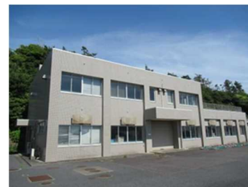
水産加工実験棟
