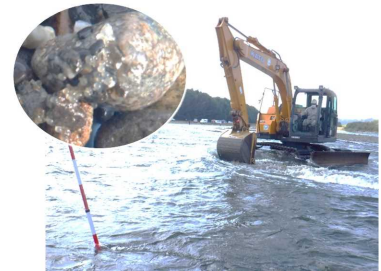
重機を活用したアユの産卵場造成
