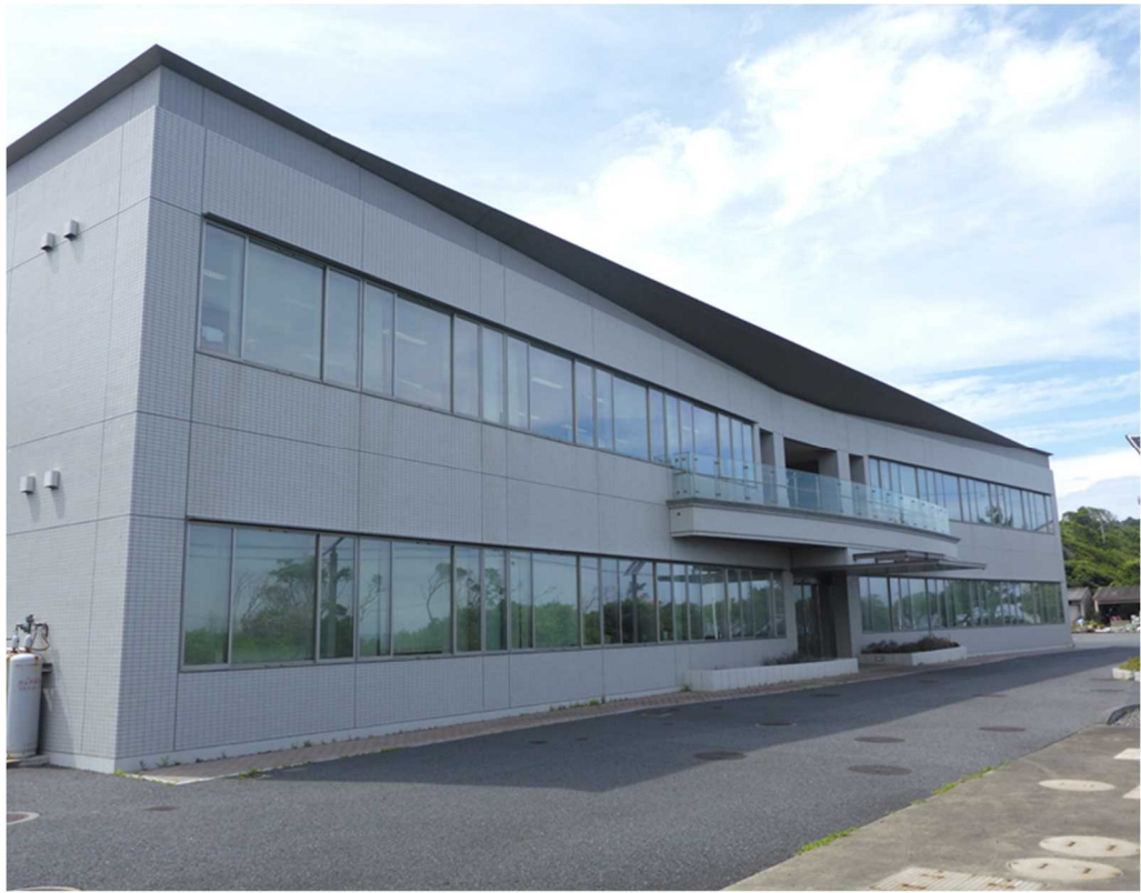
水産試験場 本館
