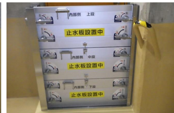
止水板の設置例
