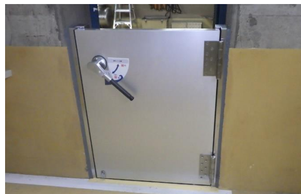
止水板の設置例
