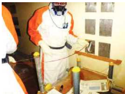
① セル内観察作業風景 (点検口から点検装置を挿入)
