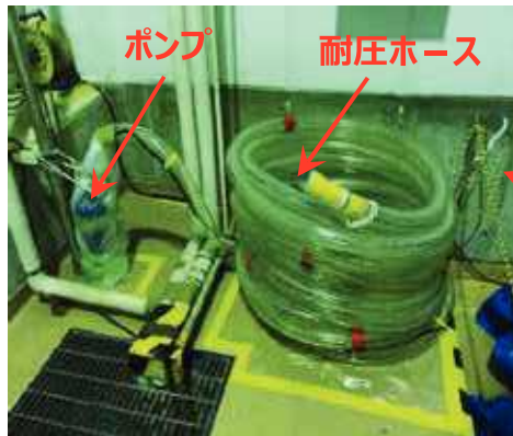
資機材の配備状況
