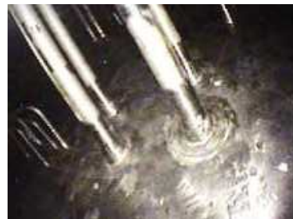
②貯槽上部配管の観察 (予備貯槽)
