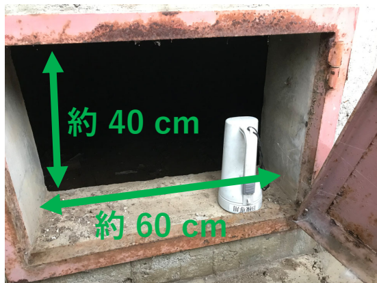
第一実験棟床下入口
