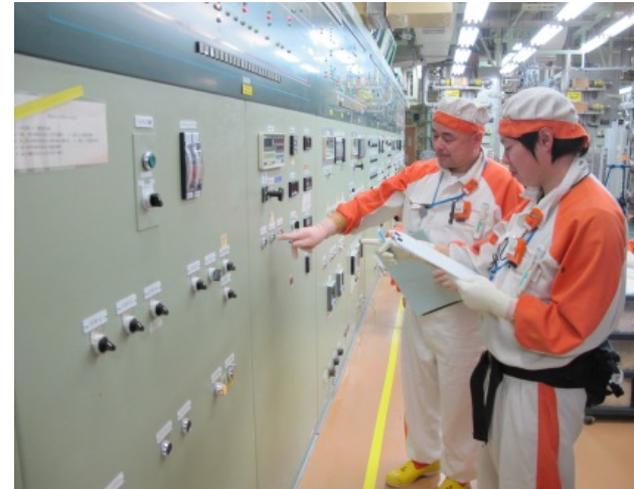
粉碎工程制御盤での操作訓練(ランプテスト、操作スイッチ確認)
