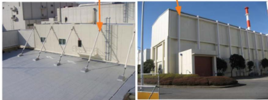
分離精製工場燃料貯蔵プール屋根の鉄骨補強
