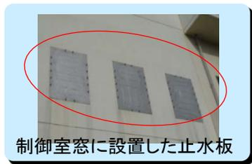
制御室窓に設置した止水板
