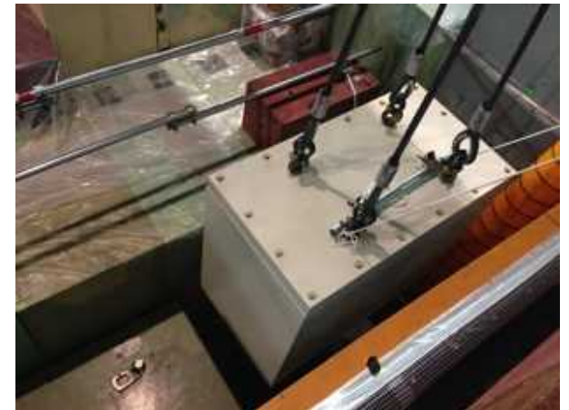
保管容器を放射化物保管庫へ収納
