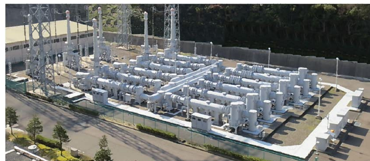
ガス絶縁開閉装置(イメージ)
