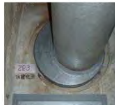
貫通部の止水処置(例)
