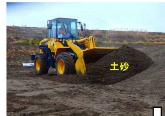
重機により土砂を撤去
