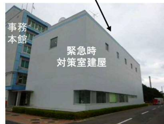
緊急時対策室建屋 (当時施工中)*
