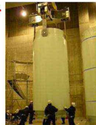
⑤ 乾式キャスクの移動作業
