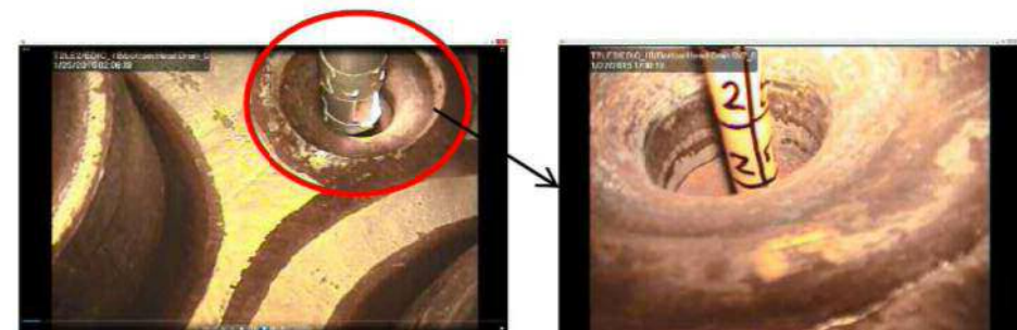
目視試験の様子
