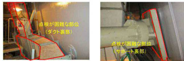
例 ダクト裏部
