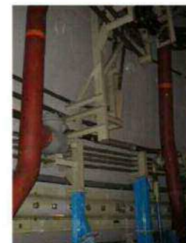
仮設足場組立前
