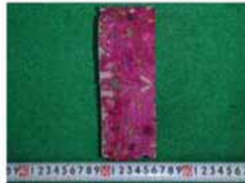
③中性化深さの点検状況 (フェノールフタレイン溶液による確認)
