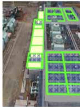
海水ポンプ室
