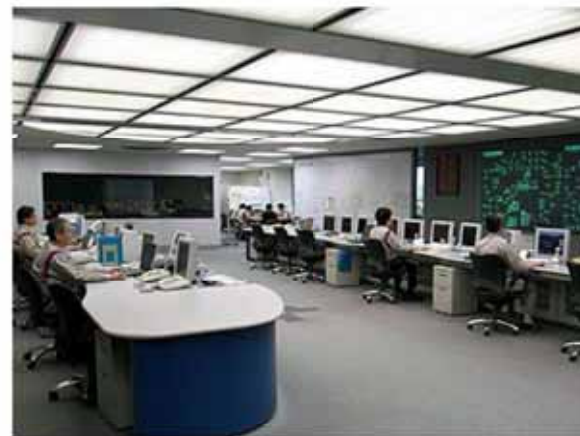
東京ガス(株) 供給指令センター
