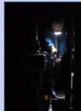
可搬照明を使用した状態での弁の開閉操作
