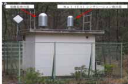
モニタリング・ポスト(既存設備)による放射線量の測定
