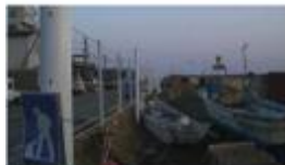
津波漂流物の捕捉状況の例(十勝港)
