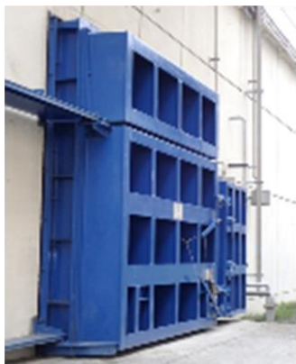
建家外側の状況(スライド式浸水防止扉)
