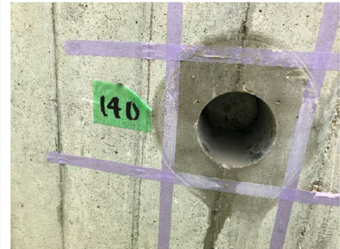
コンクリート試験片採取
