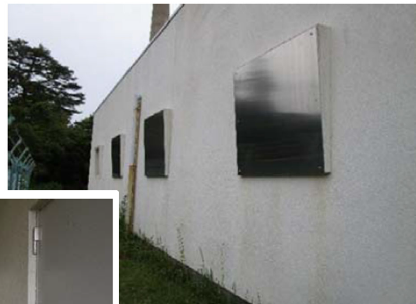
ホットラボ実験棟
