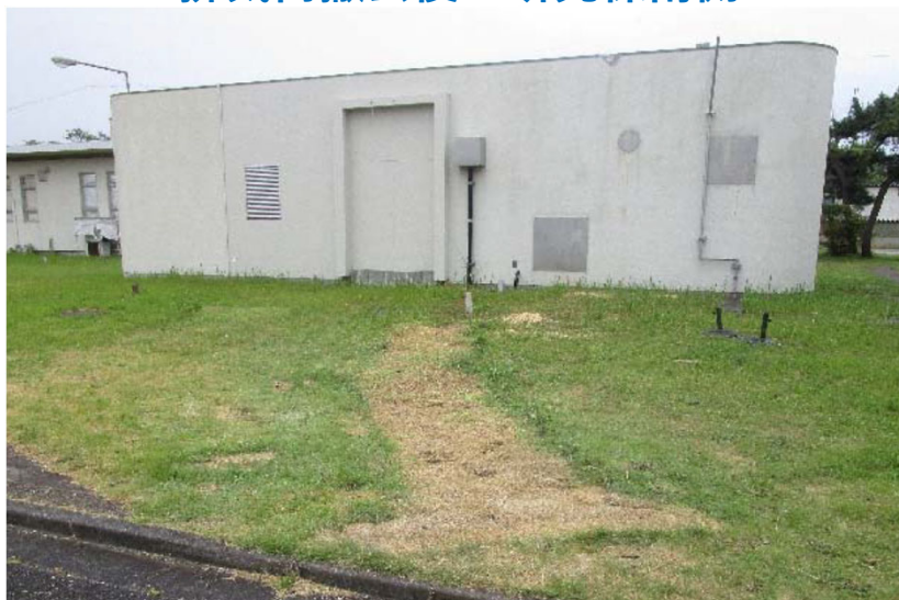
排気筒撤去後の研究棟南側
