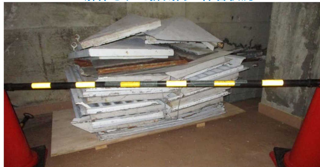
解体された排気筒の保管状況
