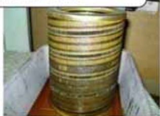
写真① タービン駆動原子炉給水ポンプ (A) 制御油フィルタ
