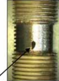
7月22日 漏えい孔確認
