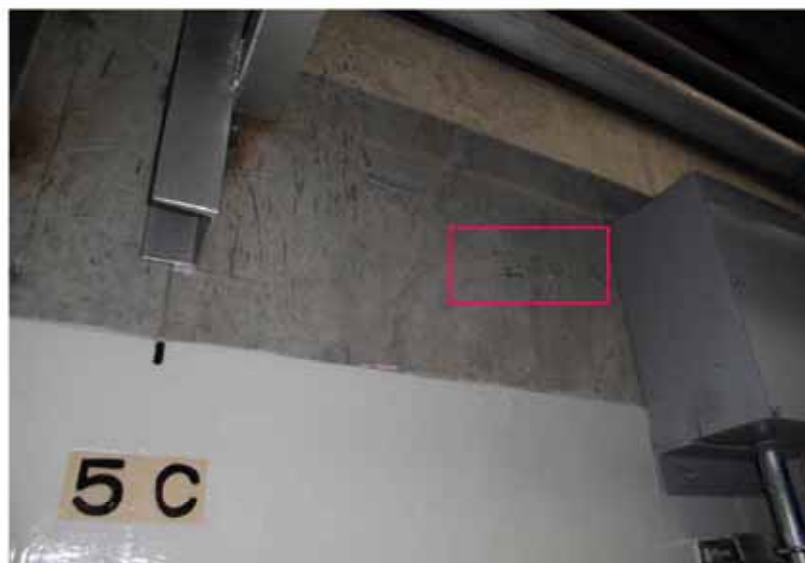
原子炉建屋3階壁面
