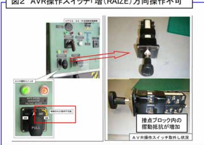
図2 AVR操作スイッチ「増(RAIZE)」方向操作不可
