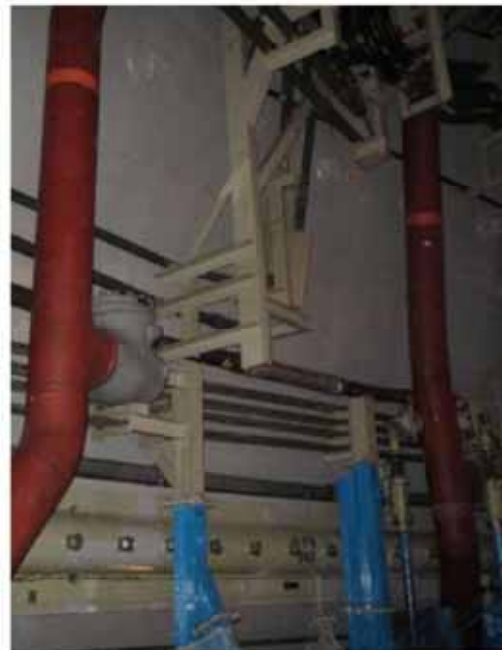
仮設足場組立前
