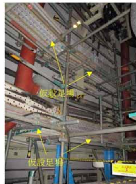
仮設足場組立後
