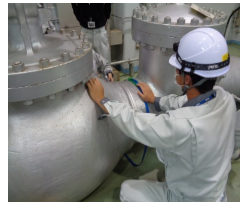
BDBA対応訓練 (配管漏えい時の応急措置訓練)
