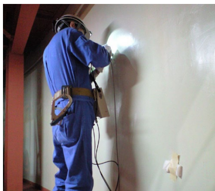
ひび割れ調査
