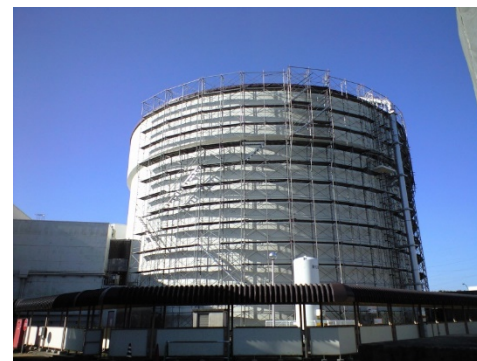
原子炉建家の足場
