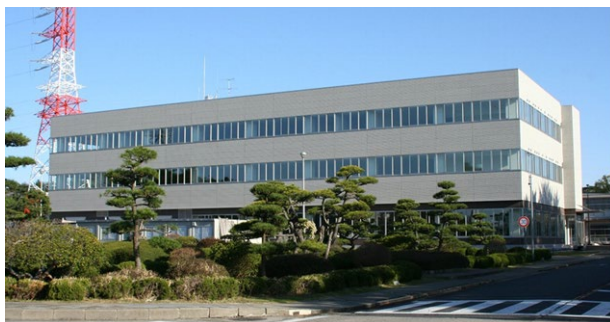
緊急時対策所
