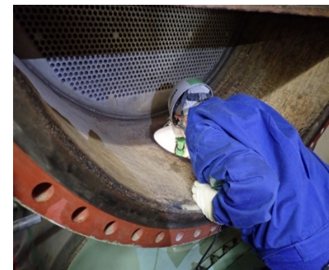
1次冷却材熱交換器の開放点検
