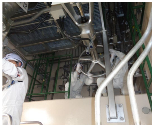
BDBA対応訓練 (1次冷却系の弁の手動操作訓練)
