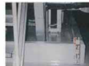
防油堤の設置
