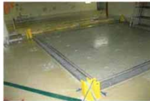
支柱レールの取付状況例
