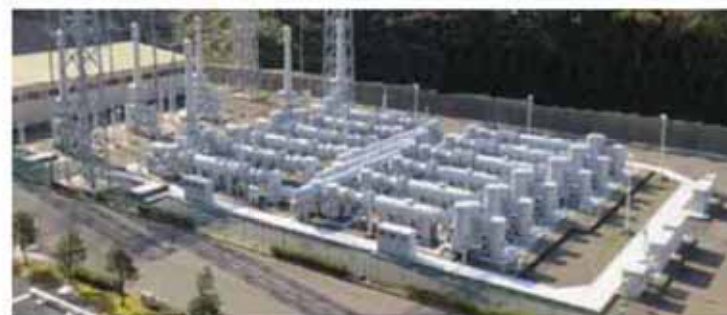
ガス絶縁開閉装置(イメージ)
