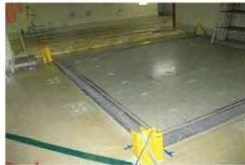
支柱レールの取付状況例
