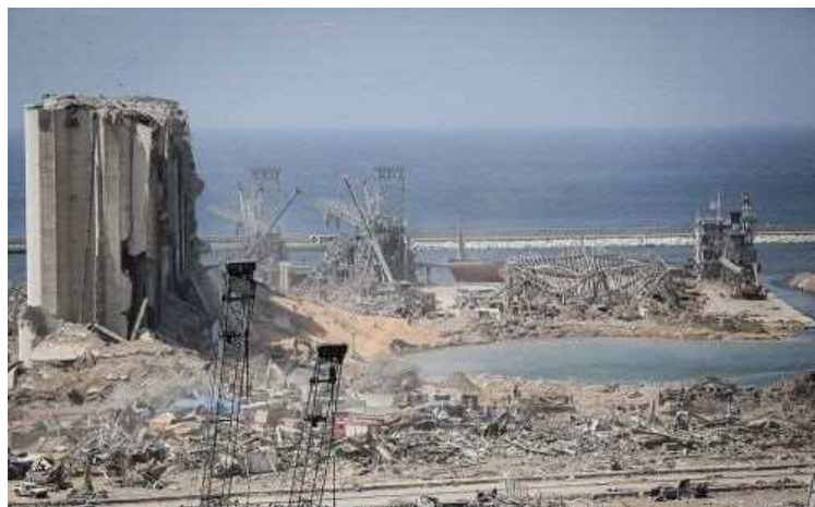
破壊された穀物倉庫(左)と爆発現場のクレーター(右)
