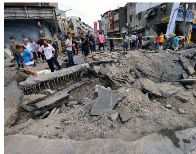
ガス爆発現場の状況
