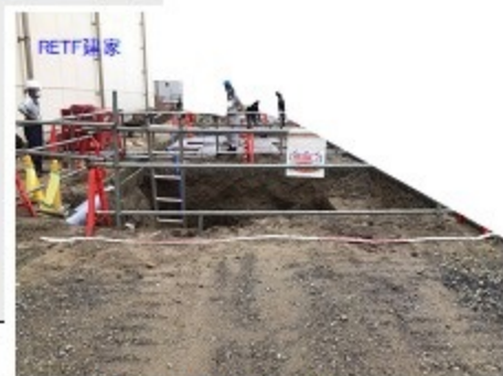
[南面工区 舗装撤去・試掘調査中]
