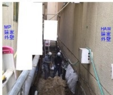
[北面工区 手作業による掘削]
