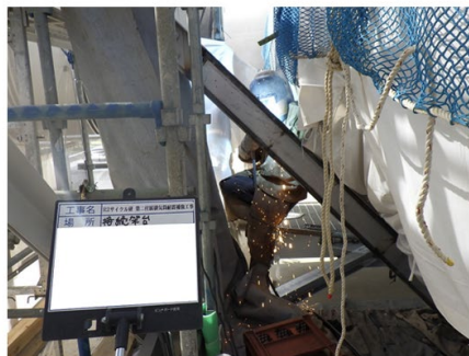
[補強部材の溶接による取付]
