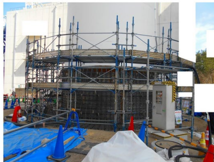
[排気筒下部への配筋施工]
