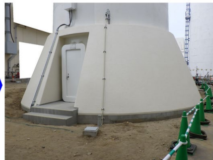
[排気筒下部補強工事完了]
