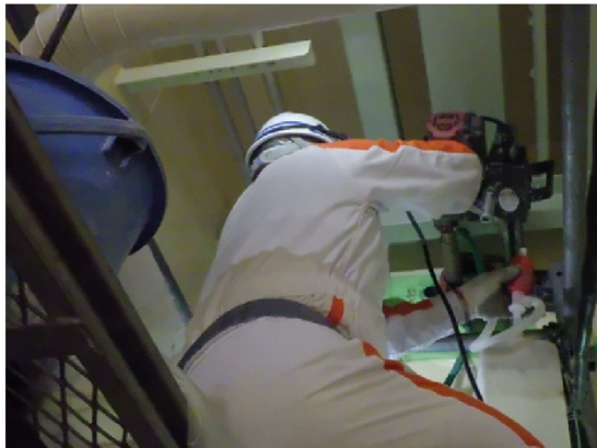
[壁のコア抜き調査]
