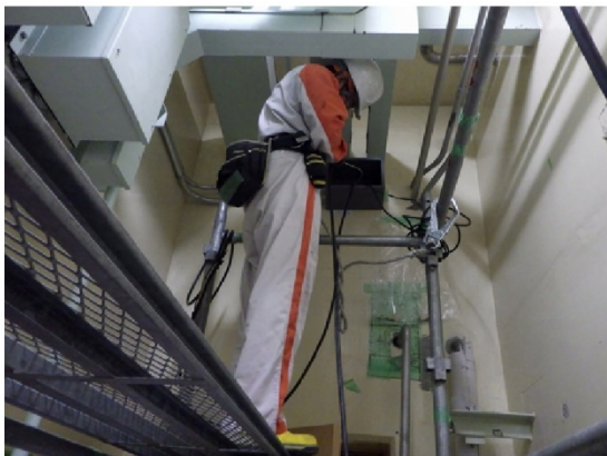
[工事エリア周辺の電線管等の移設作業]
