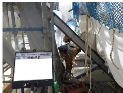
[補強部材の溶接による取付]
