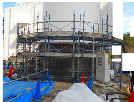
[排気筒下部への配筋施工]
