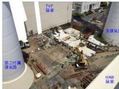
【西面工区 掘削工事・コンクリート打設】
