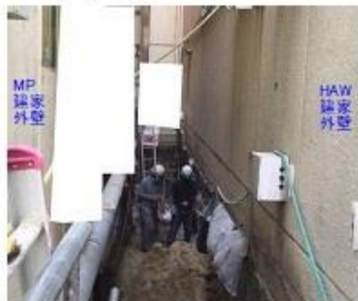
【北面工区 手作業による掘削】
