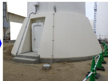
[排気筒下部補強工事完了]
