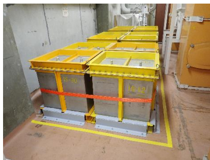
ヨウ素フィルタ保管容器の連結・床面への固定
