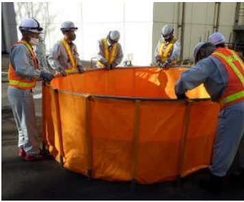
組立式水槽の設置
