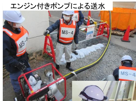
エンジン付きポンプによる送水
