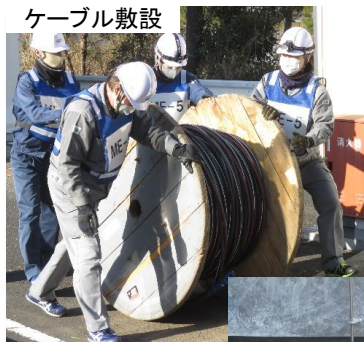
ケーブル敷設
