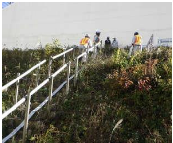
法面でのホース敷設
