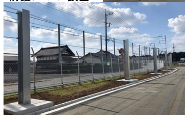
防護フェンス設置
