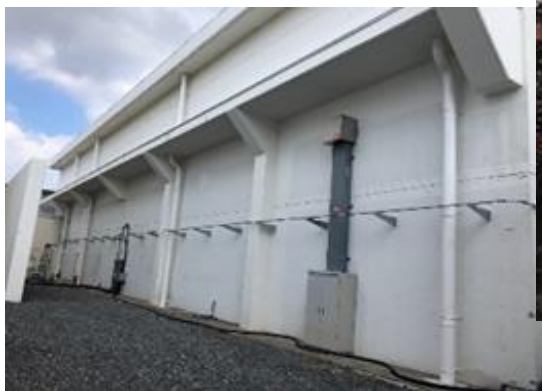
外壁補強(スラブ設置)
