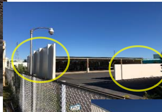
高圧ガス貯蔵所障壁設置
