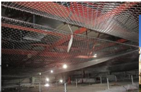
天井裏防護ネット設置
