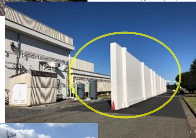
独立遮蔽壁設置
