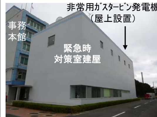
緊急時対策室建屋 (当時施工中)*
