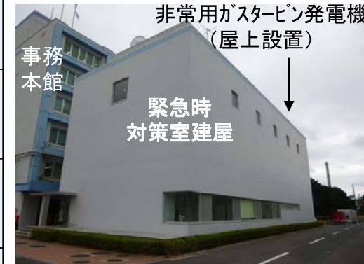
緊急時対策室建屋 (当時施工中)*
